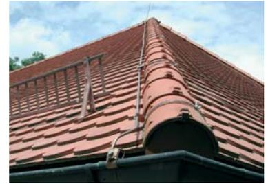
Fig. 5.2.2.1.3: Instalación captadora con conexión al canalón del tejado.
