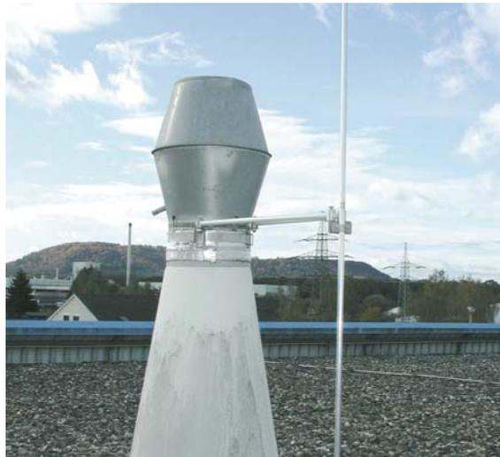
Fig. 5.1.8.3: Punta captadora con soporte distanciador.
