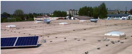
Fig. 5.1.3.3: Uso de puntas captadoras.
