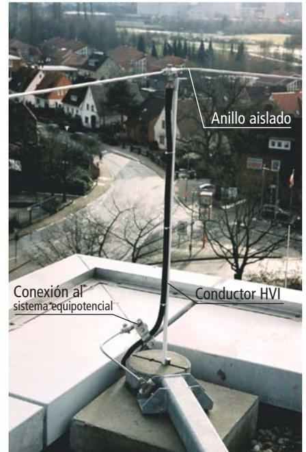
Fig. 5.2.4.3.3: Derivador de anillo aislado.
