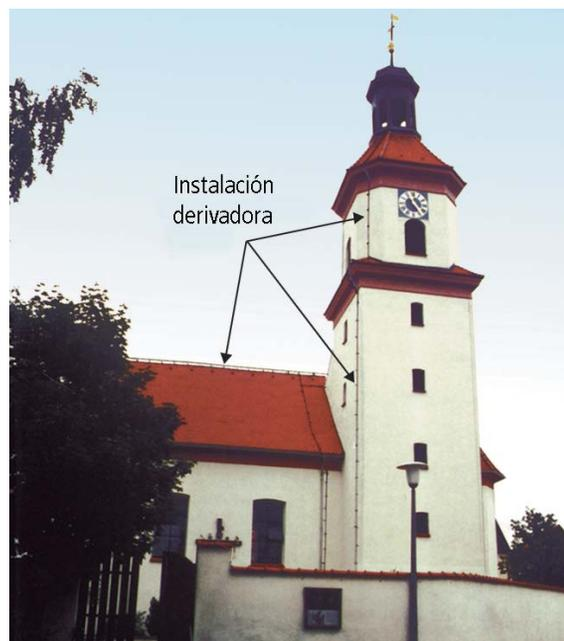
Fig. 5.1.9.1: Tendido de los derivadores en una torre de iglesia.
