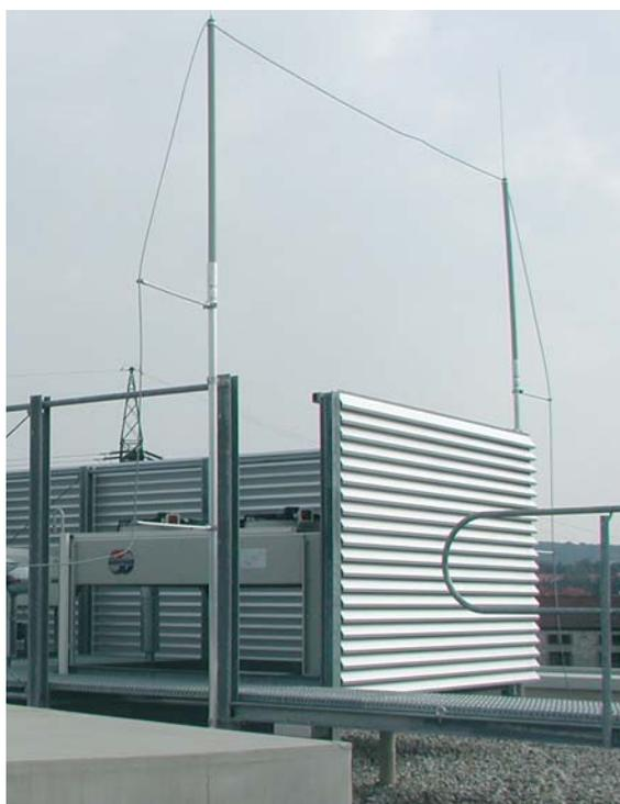
Fig. 5.1.8.14: Instalación captadora aislada con DEHNiso-Combi.
