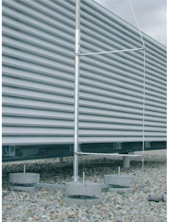
Fig. 5.1.8.11: Trípode para tubos auto soportados aislados.
